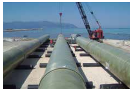
▶ Emisor submarino Tecnimont, Albania Diámetro (DN): 1,800 mm Longitud: 1,000 m
