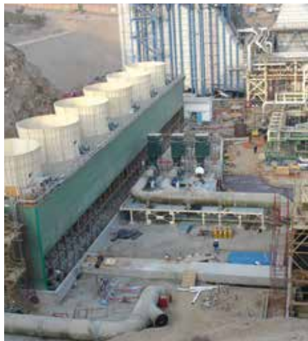
▶ Sistema de agua de enfriamiento - Planta de energía Ventanilla, Perú Diámetro (DN): 25 - 1,800 mm Longitud: 1,000 m
