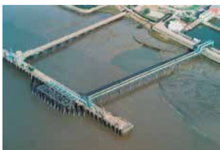
▶ Planta de tratamiento de agua residual río Támesis, Inglaterra Diámetro (DN): 1,400 mm Longitud: 400 m
