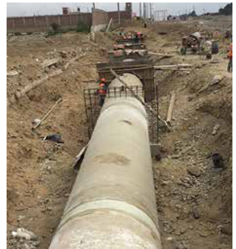
▶ Cambio de colector, SEDALIB, Perú Diámetro (DN): 1,800 mm Longitud: 100 m
